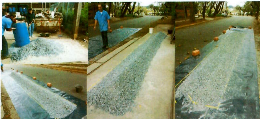
Figura 26 - Homogeneização e pilhas Chevron, Strata e Windrow.
